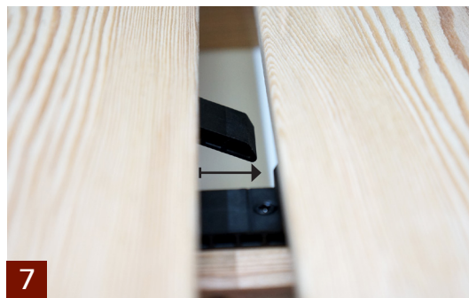
7 Skub profilen ind over allerede monterede clips.
